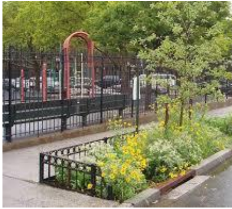
Hình 43. Tận thu nước mưa tại chân công trình gom về các bể chứa nước nhằm tái sử dụng
