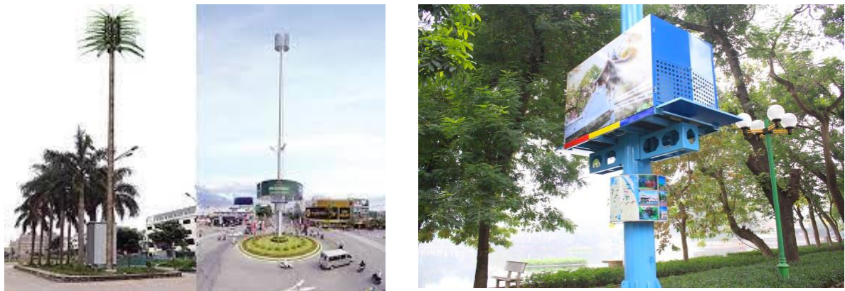
Hình 47. Các loại trạm BTS công nghệ mới đảm bảo mỹ quan và an toàn
