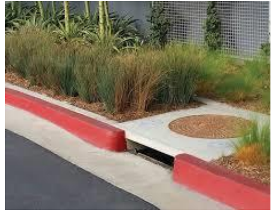
Hình 43. Tận thu nước mưa tại chân công trình gom về các bể chứa nước nhằm tái sử dụng
